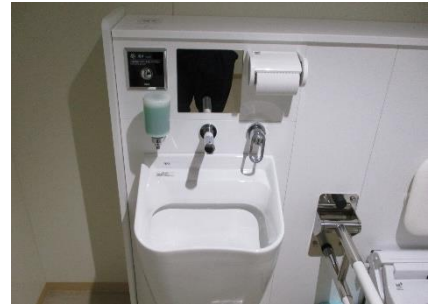
5階多目的トイレ
