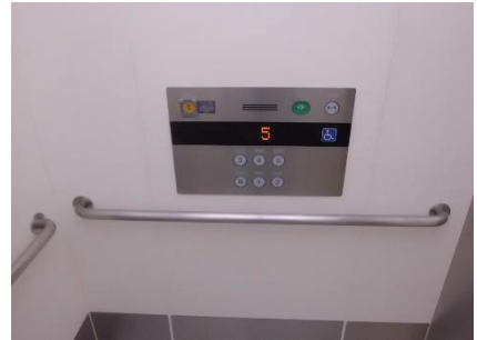
エレベーター内
