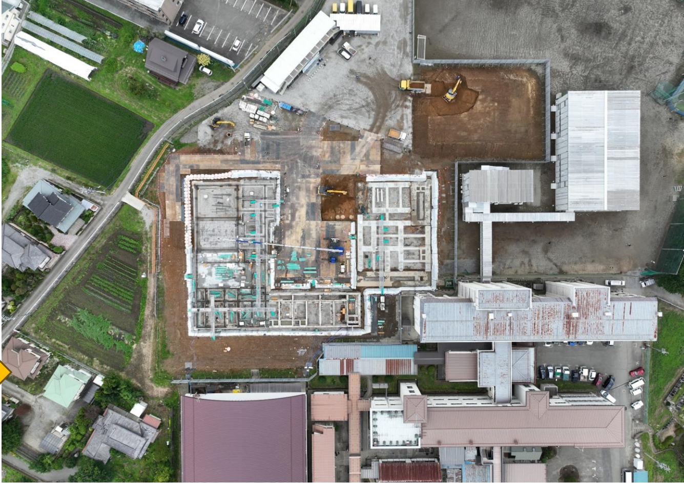
2026.06.30基礎工事施工状況
