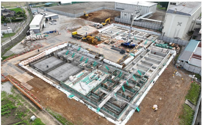
2026.06.30基礎配筋～型枠～コンクリート打設実施状況
