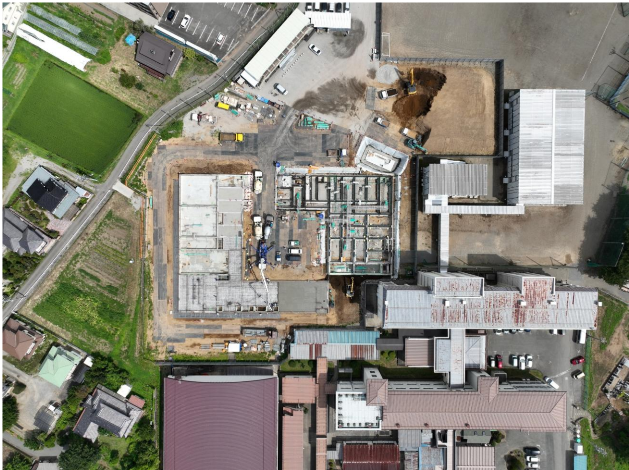
2026.07.31土間コンクリート打設施工状況
