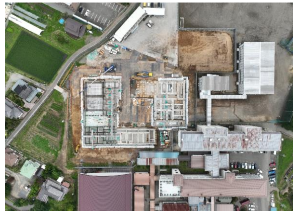
2026.07.15基礎型枠施工状況
