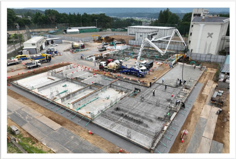
2026.07.31 基礎配筋～型枠～土間コンクリート打設実施
