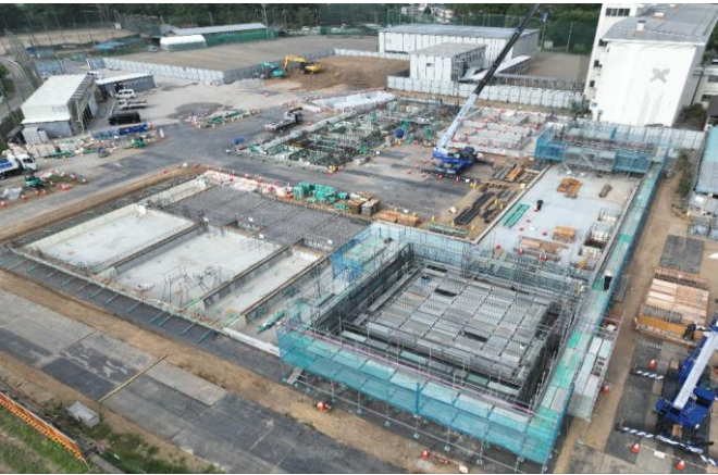
2026.08.03 壁配筋施工状況
