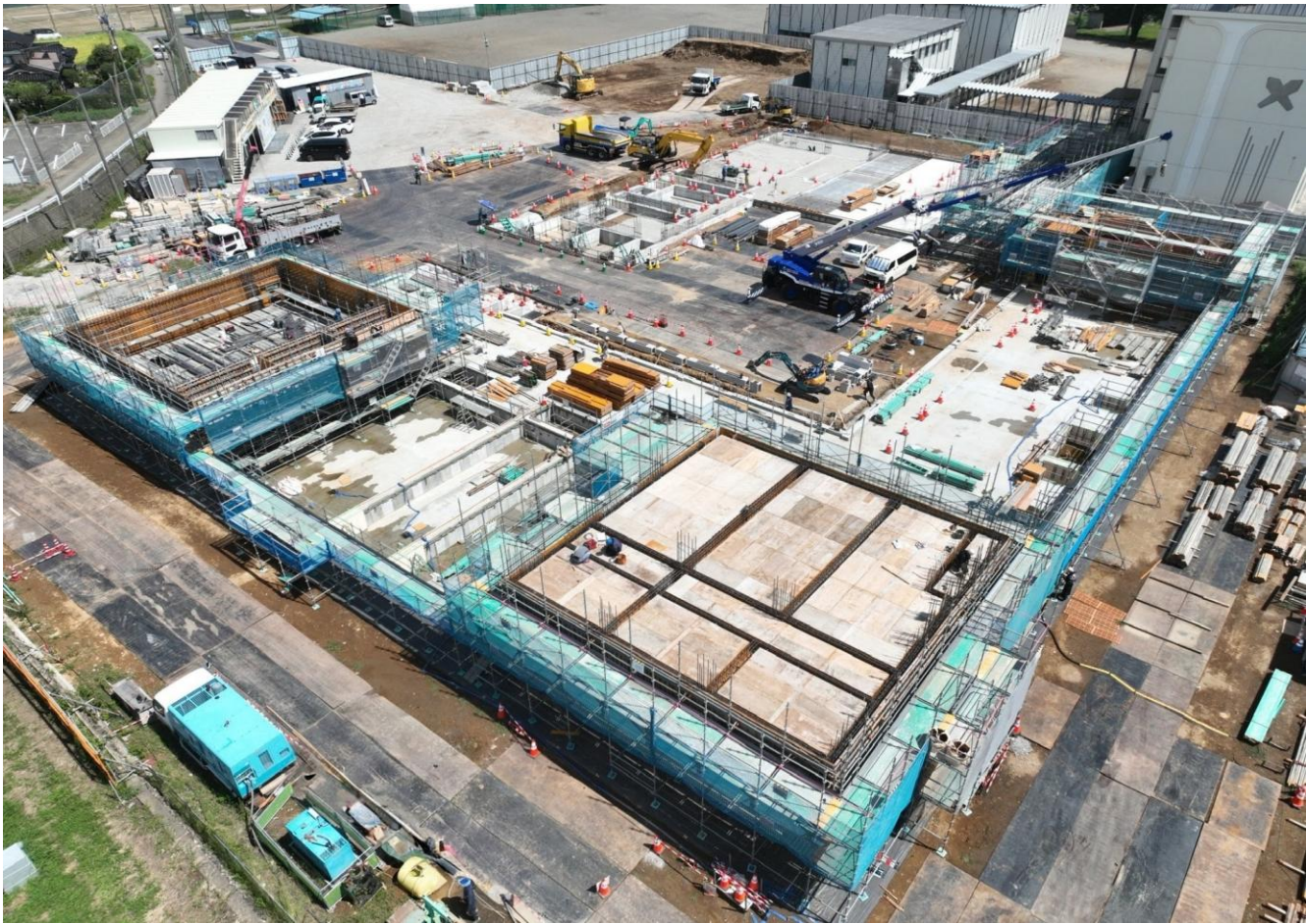
2026.08.31 2階床型枠施工状況
