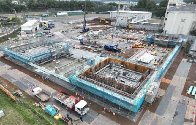
2026.08.01～2026.08.31 工事進捗 時系列 写真状況
