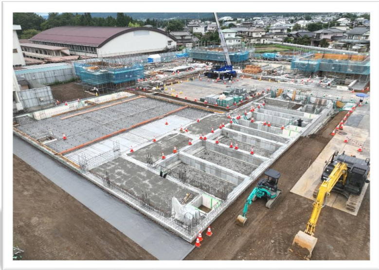
2026.08.31 北東側より鳥瞰 基礎～土間配筋～1階壁配筋・型枠実施状況
