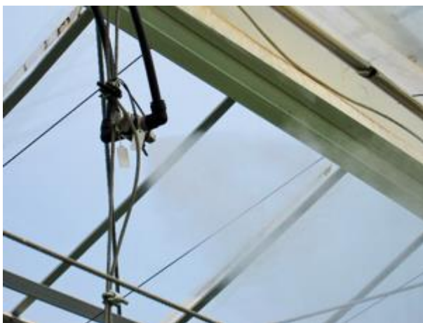
二流体方式による細霧冷房
