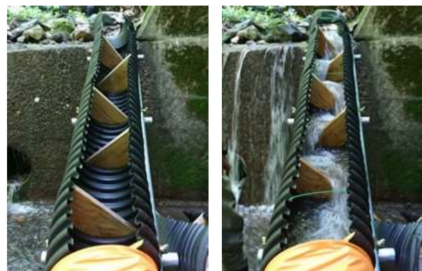
図 2 隔壁を設置した様子 (左：通水前、右：通水後)
