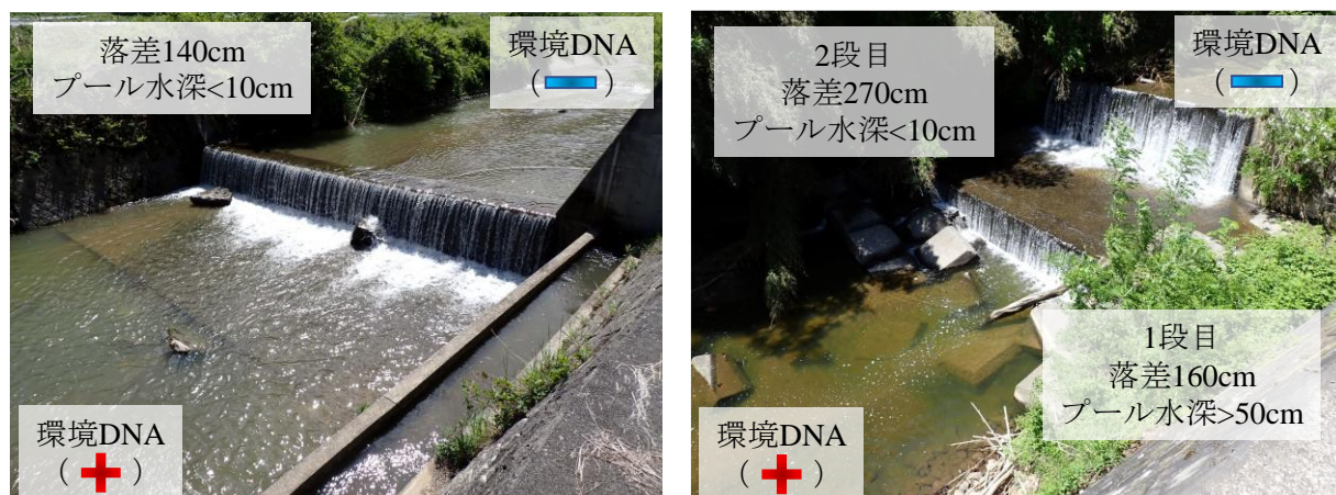
図2 犀川支流の金熊川の No.1 (左) および当信川の No.1 (右) における本種の環境 DNA 種特異的解析で下流域が陽性、上流域が陰性であった河川横断構造物 (図中の (+) は陽性、(-) は陰性を示す)
