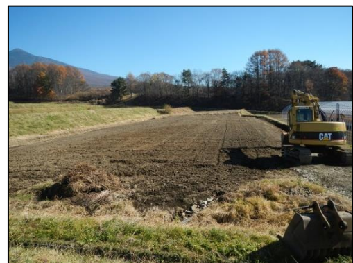
写真45 R5年1月 盛り土実施後の様子
