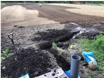
写真 23 流末の確保 スムーズな排水のため、流末付近は 50 cm以上の掘削を実施
