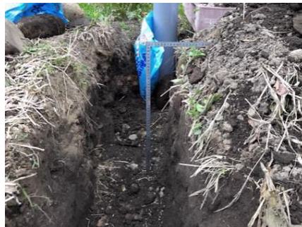
写真 23 流末の確保 スムーズな排水のため、流末付近は 50 cm以上の掘削を実施
