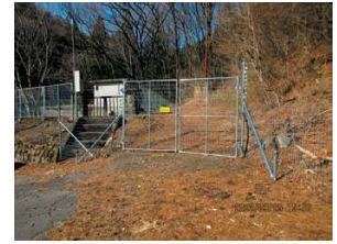
【獣害対策の防護柵整備】
