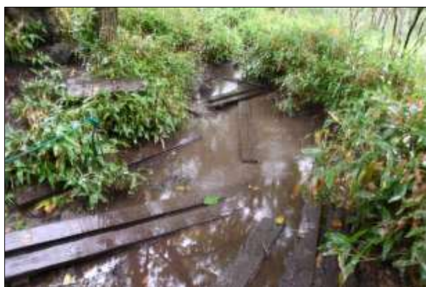
図3 降雨後の様子
