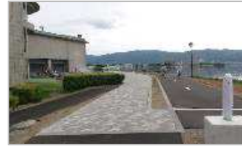
岡谷市施工 あいとびあ横
