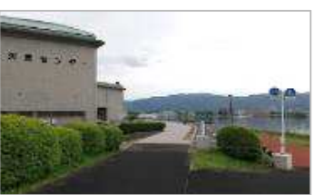
諏訪市施工 諏訪湖間欠泉センター付近
