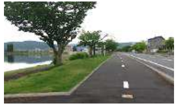
下諏訪町施工 AQUA未来付近
