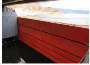
諏訪湖の水をせき止める仮設ゲート
