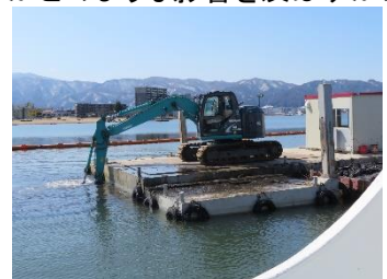
浚渫工事の様子(遊覧船上より)
