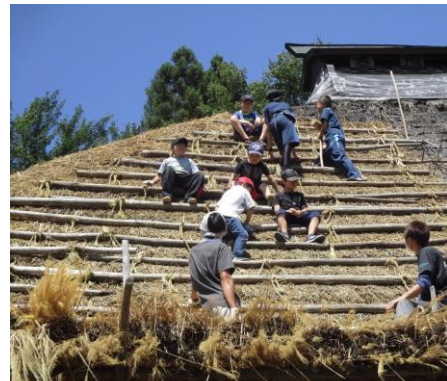
【茅葺作業の様子】
