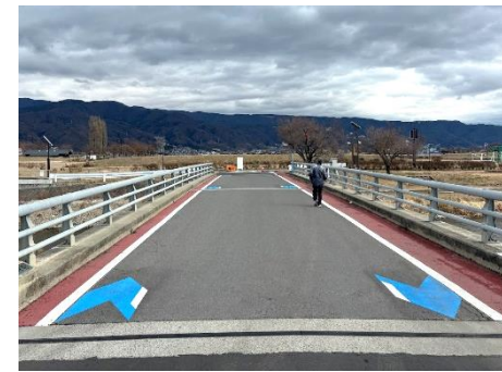
歩行者・自転車・自動車が混在通行する橋梁部における安全対策
