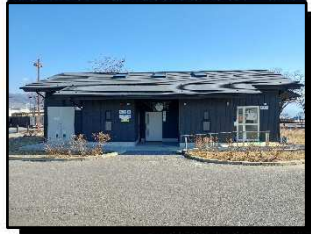
諏訪湖畔公園のトイレ
