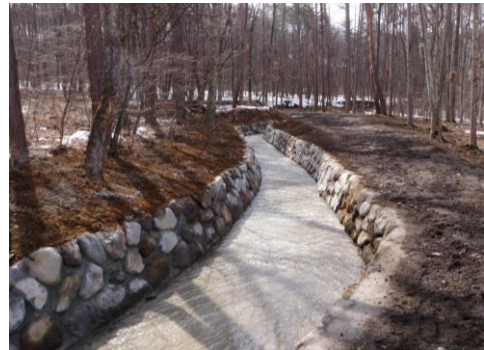
改修された滝之湯堰
