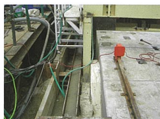
▲裏込注入状況
