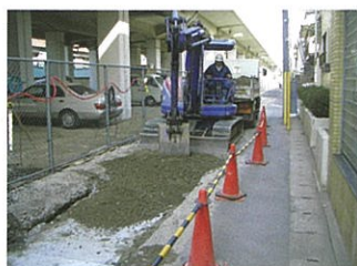
▲敷設済み函体上部は直ちに埋戻し、交通開放
