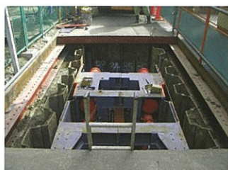
▲発進立坑内に組立てたオープンシールド機 (NOS I 型)
