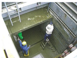
▲函体縦締用PC鋼棒緊結状況
