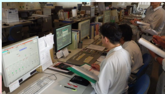
復旧作業（中央監視室）
