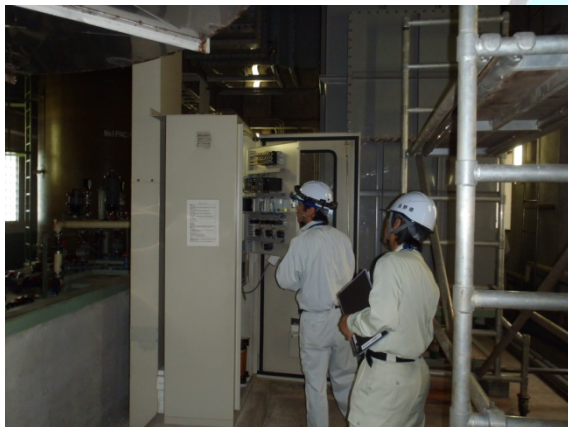
復旧作業（処理場内各所）
