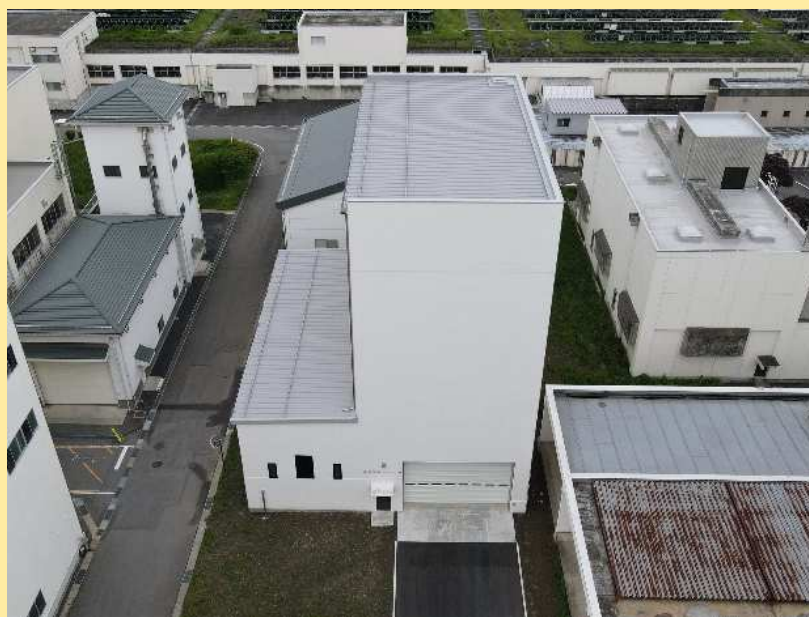
焼却灰搬出ホッパ棟（ドローン撮影）
