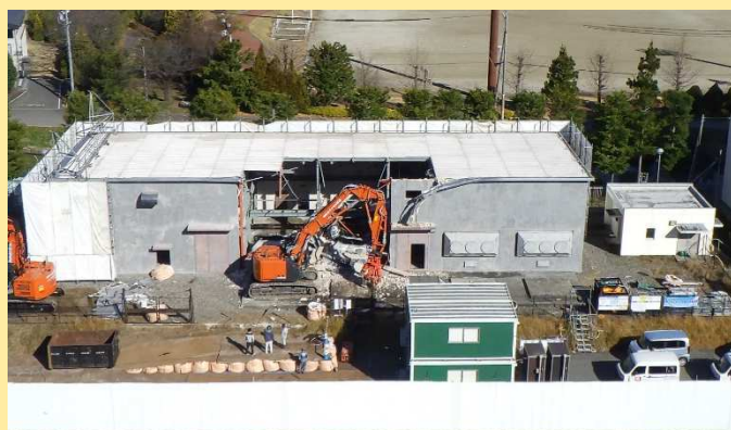
建屋解体状況
