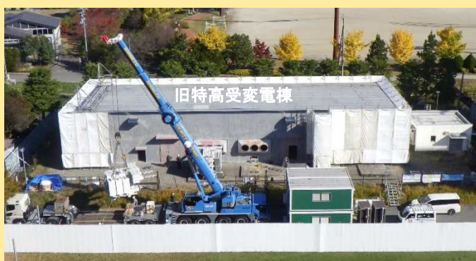
変圧器撤去状況
