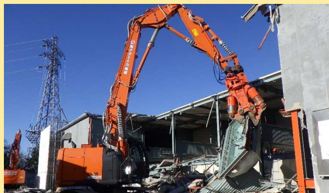
建屋解体状況
