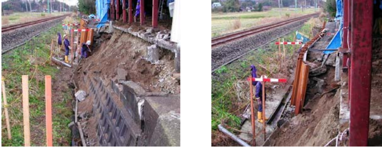
シートパイルによる擁壁仮復旧
