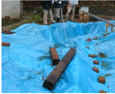
シートによる宅盤亀裂の防護
