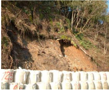
土嚢積みによる斜面の抑制
