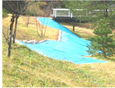
シートによる斜面の防護
