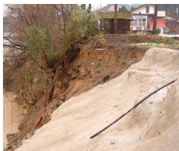
モルタル吹き付け及びロックボルトによる斜面防護
