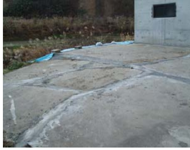
モルタル充填による宅盤亀裂の防護
