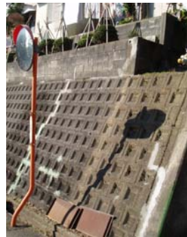
モルタル充填による亀裂の防護
