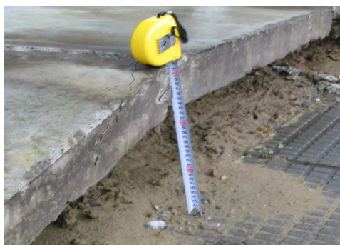
写 3-5 宅地地盤の段差の例
