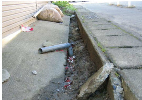
写 3-5 宅地地盤の段差の例
