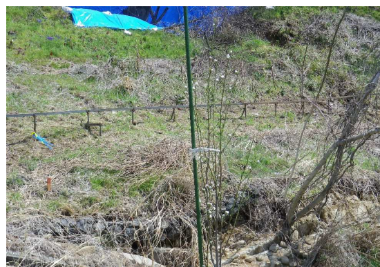
写 3-9 のり面のハラミ・盤ぶくれの例
