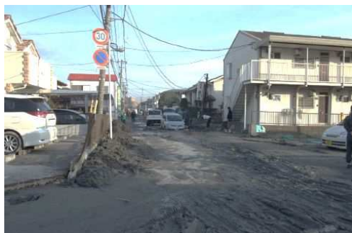
(a) 液状化の被害
