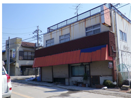
写 3-4 宅地地盤の沈下の例
