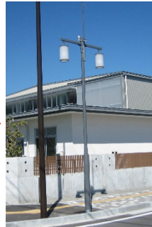
実際に設置された街路灯
