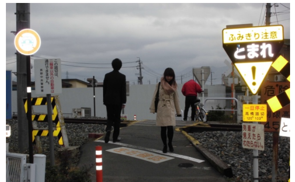
踏切を除去し、踏切事故の危険を解消
