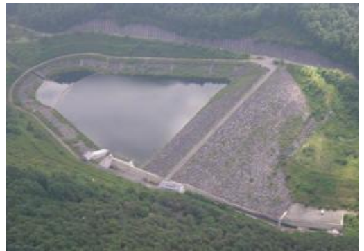
写真：金原ダム
