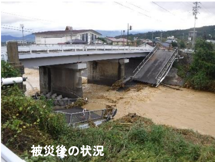
歩道橋撤去後・橋桁沈下の状況
