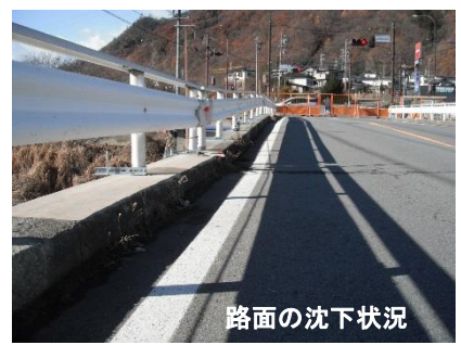
歩道橋撤去後・橋桁沈下の状況
