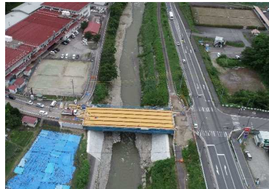
床版型枠の施工(現在)
