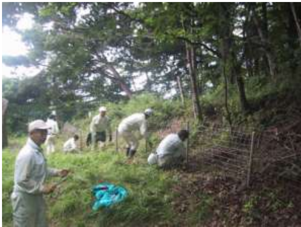
地域住民、野生鳥獣被害対策チームによる忍び返し付ワイヤーメッシュ柵の設置
