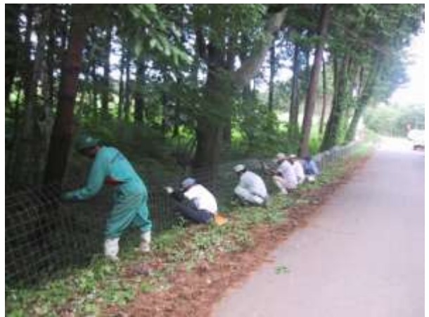
地域住民、野生鳥獣被害対策チームによる忍び返し付ワイヤーメッシュ柵の設置
