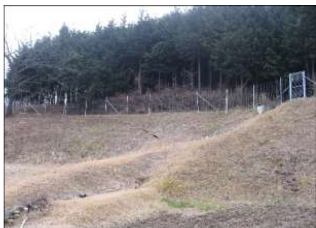
防護柵の設置状況
