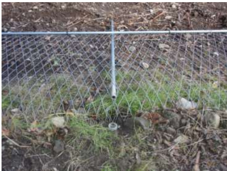
支柱は抜かない
