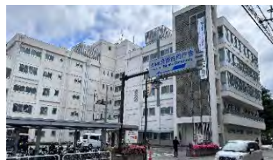
築60年を超える長野合同庁舎
