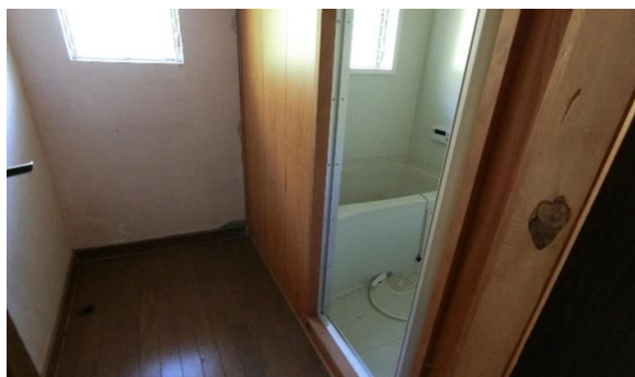
脱衣所・浴室
