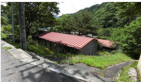
敷地4262-1北西角から
