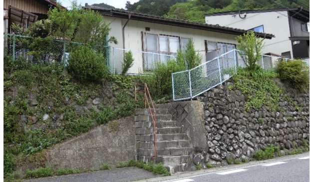
南東角から撮影
