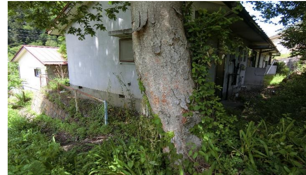
敷地4262-1北東角から
