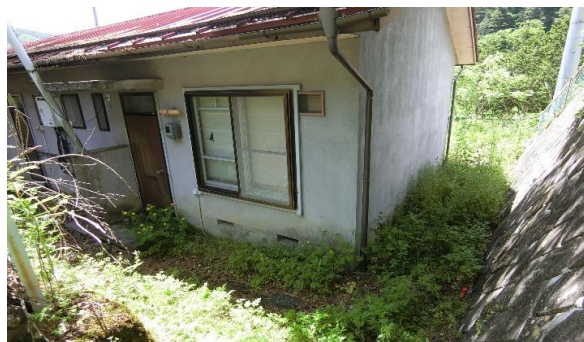
敷地4262-6北西角から
