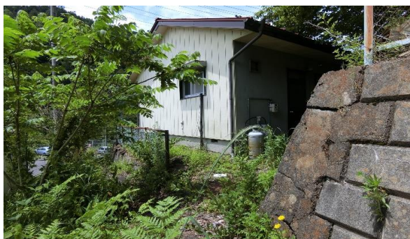
敷地4262-6北東角から
