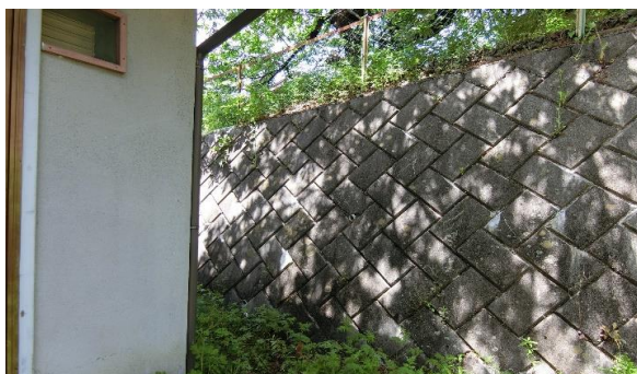
敷地4263-1北東角から
