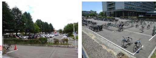
県庁敷地内にある県庁平面駐車場と駐輪場 県庁通りに面して立地するため、県庁舎入口までのアプローチを分かり難くしている
