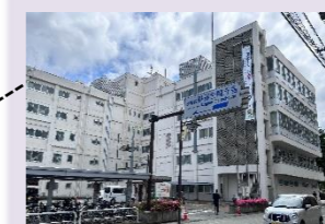
築60年を超える長野合同庁舎
