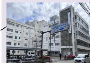
長野合同庁舎(築60年以上) 老朽化する県行政施設
