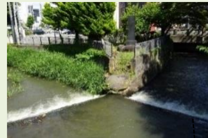
善光寺用水大口分水口 県庁舎南側に流れる善光寺用水
