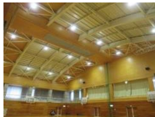
県立学校の照明交換
