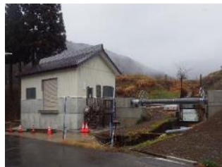
小水力発電所の設置
