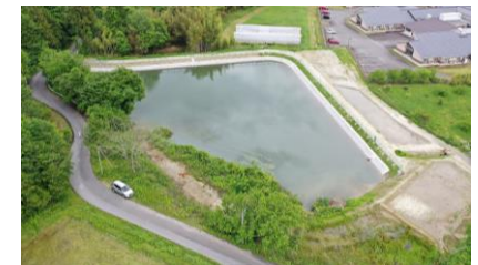
防災重点農業用ため池緊急整備
