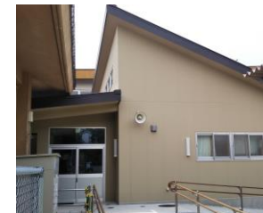
伊那養護学校の教室増築
