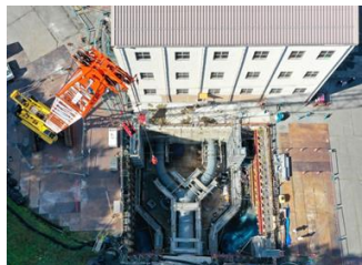
小水力発電所の設置
