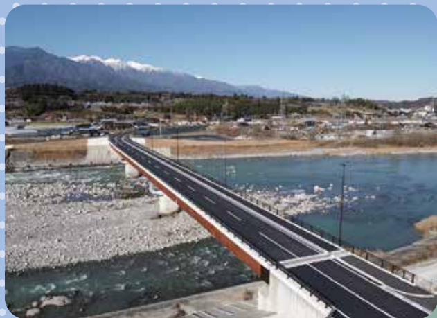
宮ヶ瀬橋（松川町）
