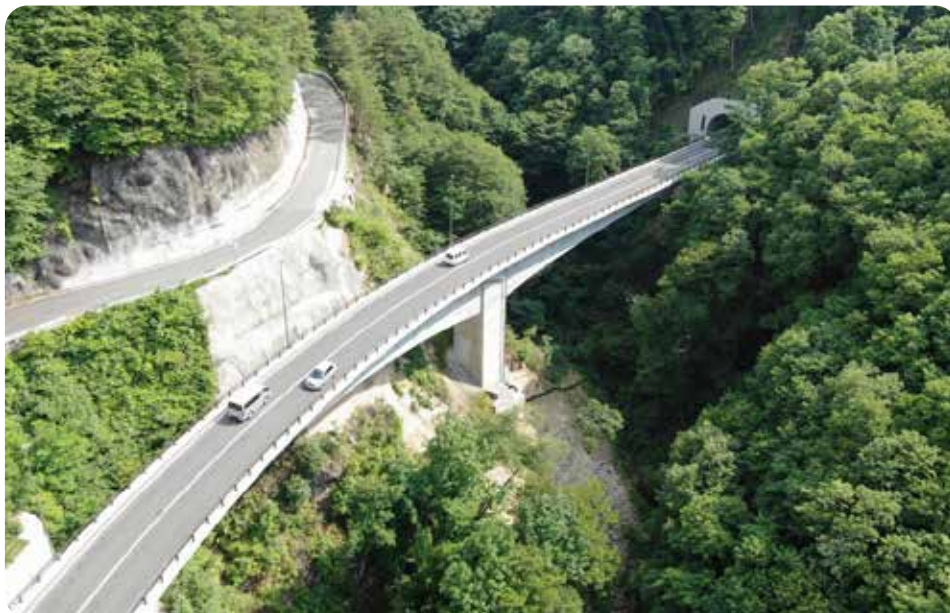
矢越トンネル・滝上大橋 (筑北村)
