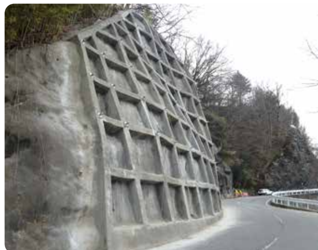
芝平高遠線 法面補修工事後（伊那市）
