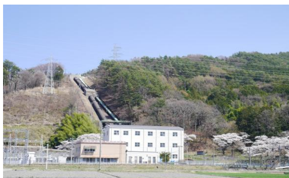
長野県企業局の春近水力発電所
