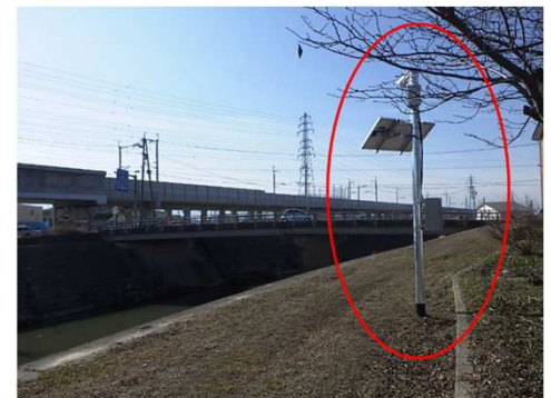
簡易型河川カメラの設置
