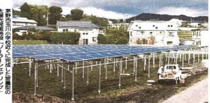
茅野市川小学校で完成した太陽光発電施設「ソーラーシェアリング」
