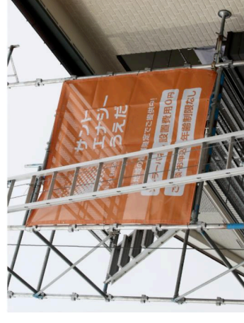
太陽光発電設備施行現場に掲げた仮囲い広告 12
